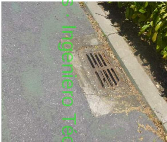
La elección de las rejillas de los sumideros y su disposición en la vía ciclista cobra importancia a la hora de evitar accidentes, por ejemplo, por la introducción accidental de una rueda en sus ranuras. Además, sus dimensiones deben ser acordes con las de la vía.
