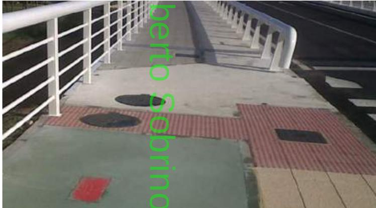
En este tramo, la vía sigue disponiendo de un carril por sentido de circulación flanqueados por dos aceras-bici, unidireccionales y con los sentidos invertidos protegidas por una fuerte barandilla del tráfico motorizado, y seguidos, hacia los extremos por una acera peatonal nuevamente, de anchura cuestionable.
