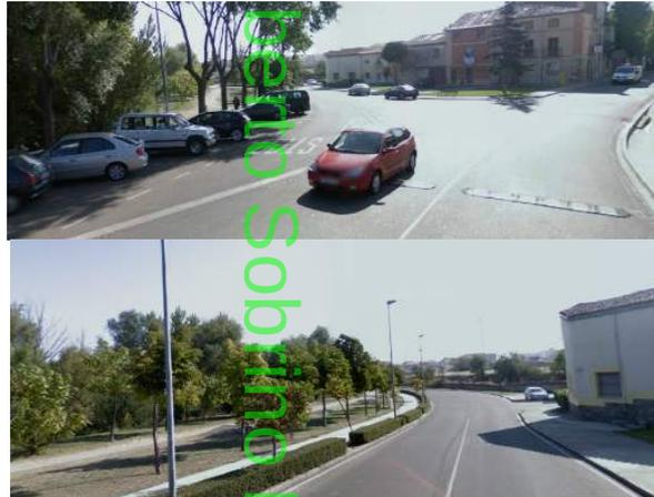
Según las imágenes, de derecha a izquierda, la vía se caracteriza por el parque existente a la derecha seguido por una acera que se separa de la calzada mediante un seto; la calzada tiene un carril por sentido de circulación y en la izquierda, una ancha franja de jardín.
